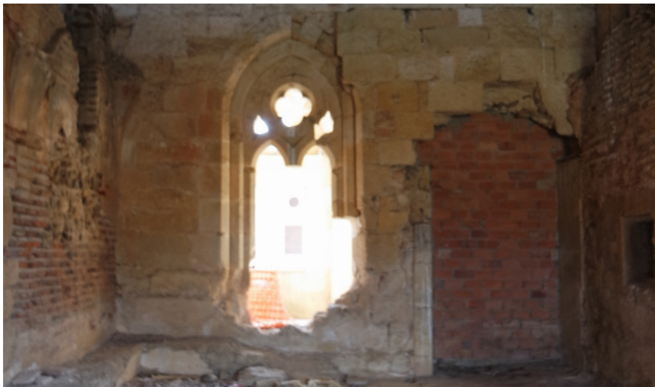
Fig 49: Hueco M.1.5. a proteger debido al mal estado de conservación del antiguo dormitorio de monjes
