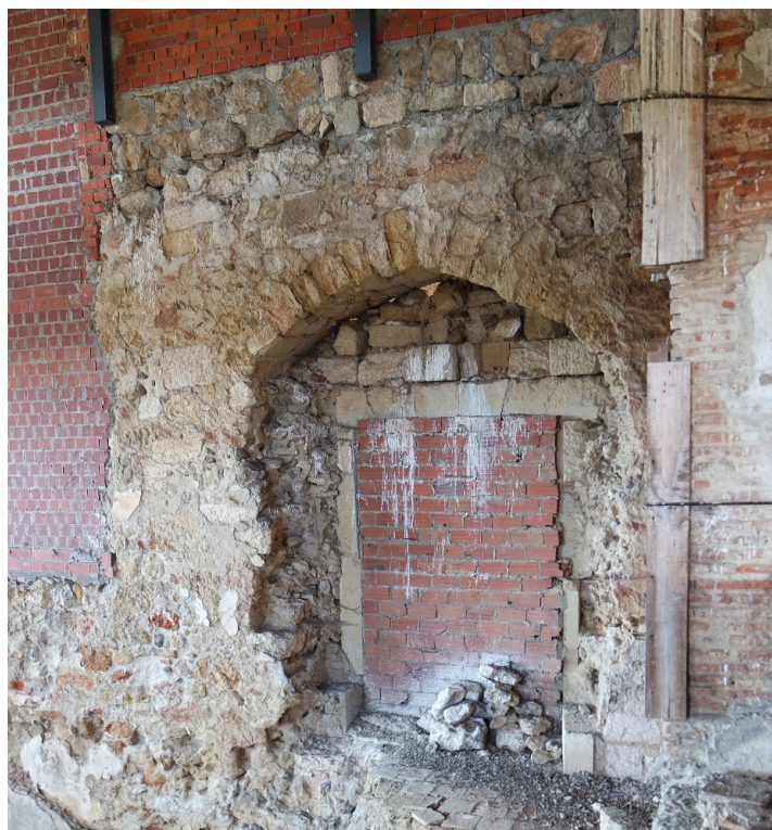
Fig 45: Hueco M.1.6. desde el dormitorio de monjes, donde se aprecia que está tapiado únicamente con ladrillo
