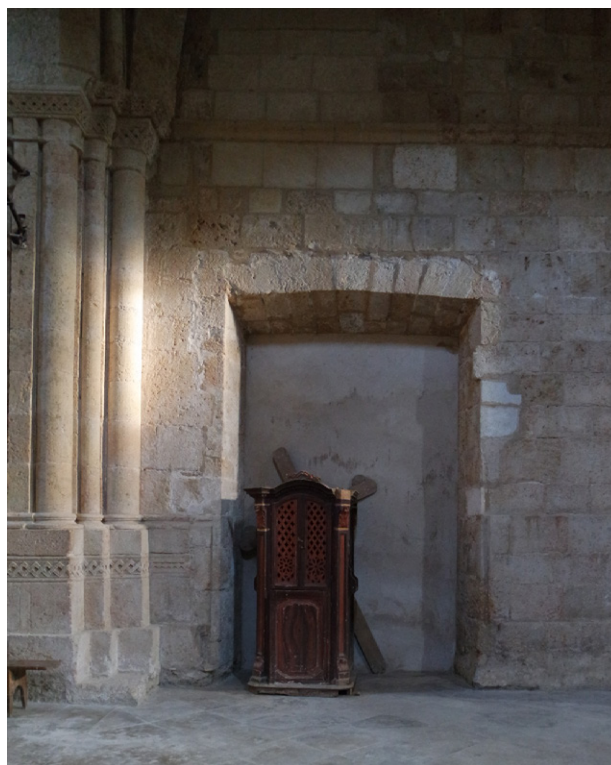
Fig 29: Hueco en el muro sur a abrir para recuperar el paso histórico entre la iglesia y el claustro
